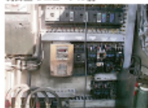
制御盤 リニューアル前
